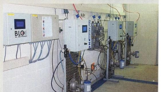
▲ Die Pumpen und die elektronisch gesteuerten 2-K-Anlagen sind in einem separaten Raum installiert
